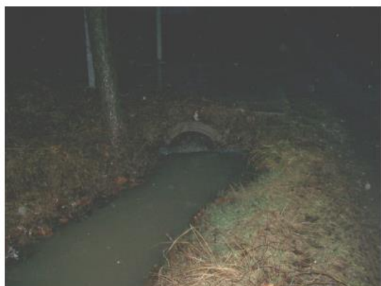
Fotografia 33 - Esempio di insufficienza idraulica di un manufatto di attraversamento del torrente Riolo (evento del 23.02.04).
