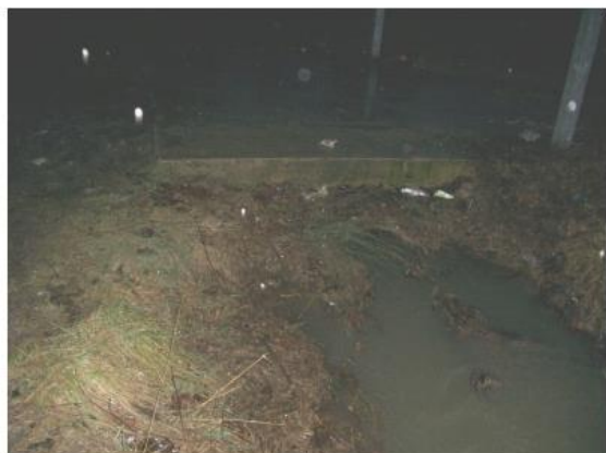
Fotografia 31 - Esempio di insufficienza idraulica di un manufatto di attraversamento del torrente Riolo (evento del 23.02.04).
