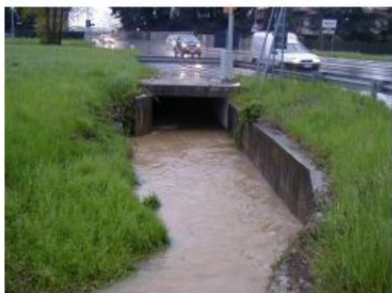
Fotografia 39 - Manufatto di attraversamento della S.P. n. 153 nel tratto terminale del Canale 1 (evento del 19.04.04).
