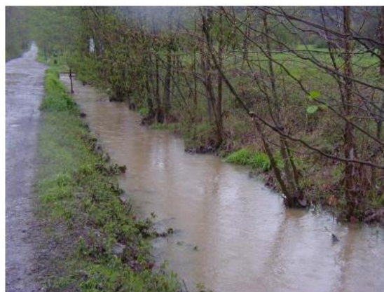
Fotografia 35 – Tratto iniziale del torrente Riolo, con ridotta capacità idraulica (evento del 19.04.04).
