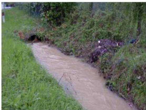
Fotografia 44 - Imbocco tratto terminale intubato del Canale 4, immediatamente a monte dell'immissione nel Canale 2 (evento del 19.04.04).
