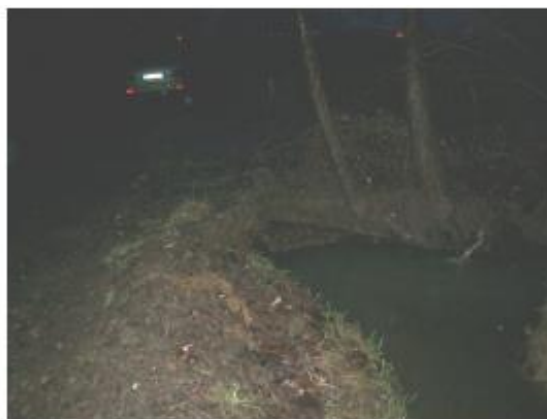
Fotografia 46 - Manufatto di attraversamento di via Pascolo dei Tedeschi nel tratto terminale del Canale 3 immediatamente a monte dell'immissione nel Canale 1 (evento del 23.02.04).
